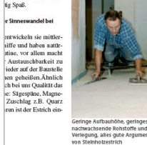
Geringe Aufbauhöhe, geringes Gewicht, nachwachsende Rohstoffe und fegeleichte Verlegung, alles gute Argumente für den Einsatz von Steinholzestrich
