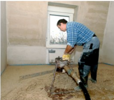
Das Einbringen des Steinholzestrichs erfolgt in der gleichen Art und Weise wie beim Zementestrich
