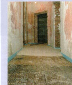
Vor allem im Renovierungs- und Sanierungsbereich eignet sich der Steinholz-Estrich besonders.
