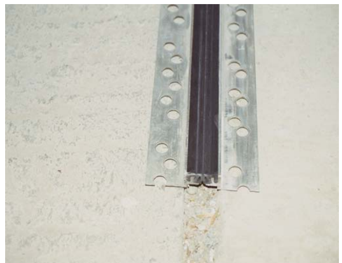
Photo: Bewegungsfuge, hier noch nicht eingebaut, vorgesehen für Verbundestrich
